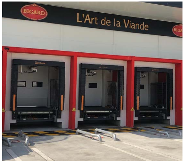
Abrigos de muelle frigoríficos se instalan directamente sobre la fachada.
