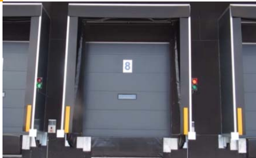
Abrigo deshinchado en reposo con las lonas plegadas.
