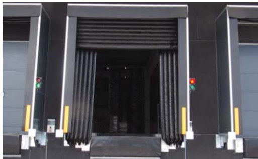
Abrigo hinchado con las lonas totalmente extendidas.
